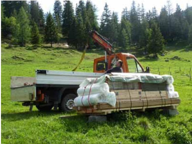
Anlieferung des Materials für die Holzhütte zur Neuwaldalm
